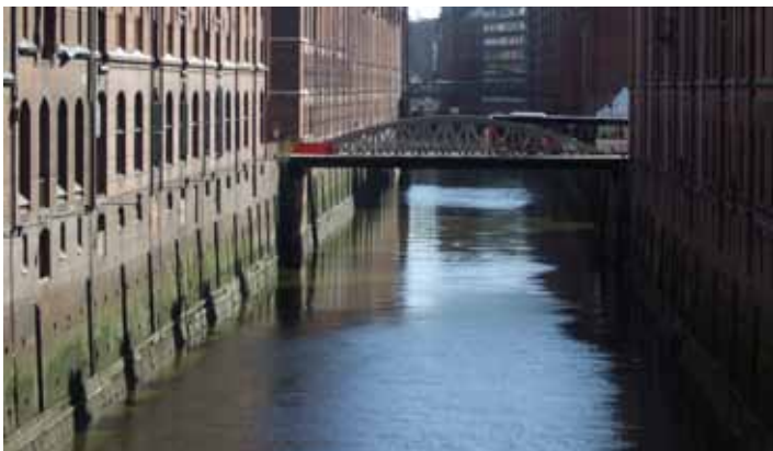
Abbildung 18: Kaimauern unter den Speicherblöcken D und L
