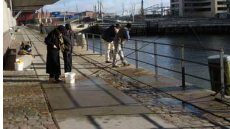
Abbildung 54: Neues Geländer am Sandtorhafen
