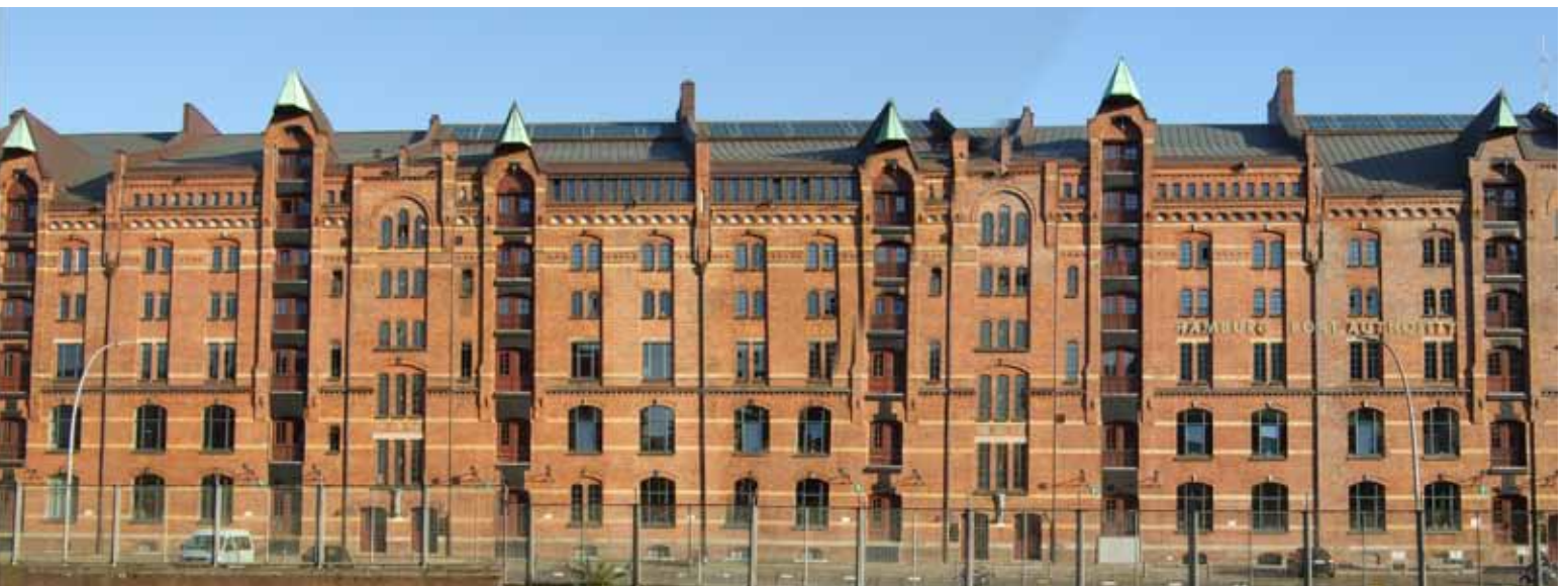
Abbildung 85: Ansicht Nord des Speicherblocks P
