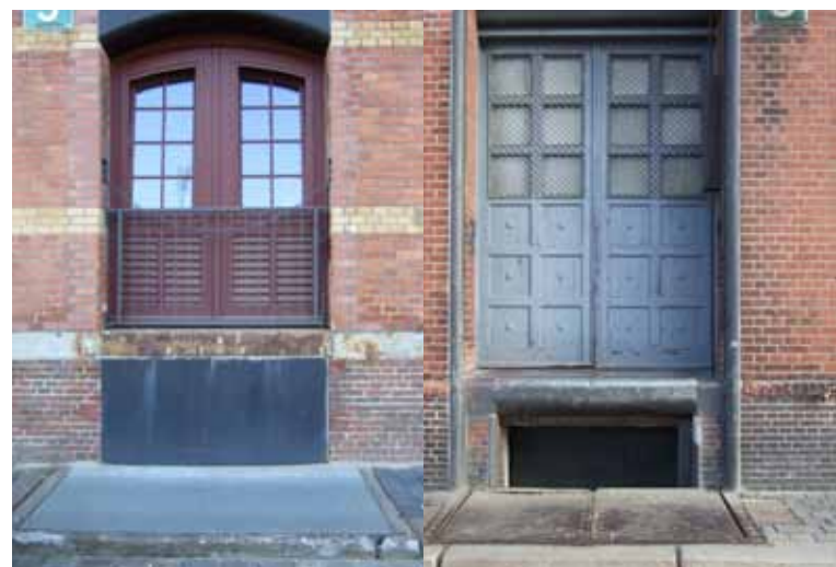
Abbildung 28: Schließung einer Kellerluke mit Beton
