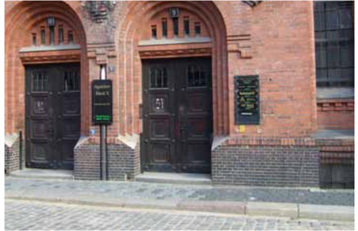
Abbildung 25: Pflasterstreifen vor den Speichergebäuden
