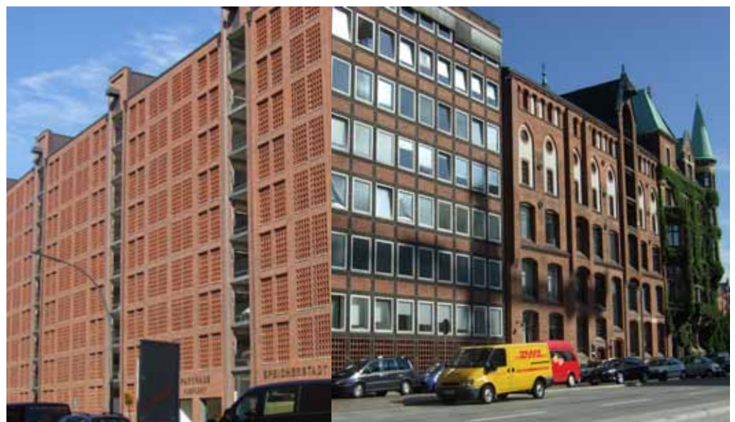
Abbildung 82: Ansicht Süd des Speicherblocks O - Parkhaus
