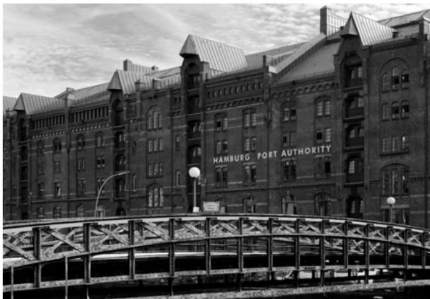
eine Sprinkleranlage musste installiert werden – ein weiteres Problem für die Ästhetiker –, die Fußböden in dem unteren Geschoss mussten einer Überflutung standhalten, fast täglich gab es mehr Probleme. Schließlich bekam das Dach eine komplett neue Kupferdeckung – dieses Detail nun wird erst in zehn bis 15 Jahren wieder denkmalgerecht grün erscheinen ...
